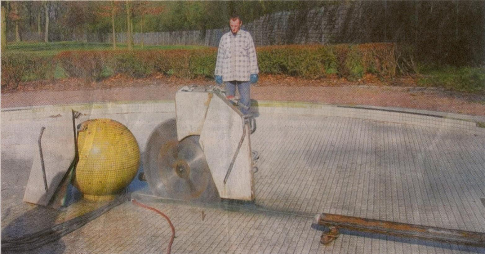
Eine riesige **Fräse** frisst sich durch den alten Boden des Kinderplanschbeckens – der erste Schritt zur **Sanierung**.
