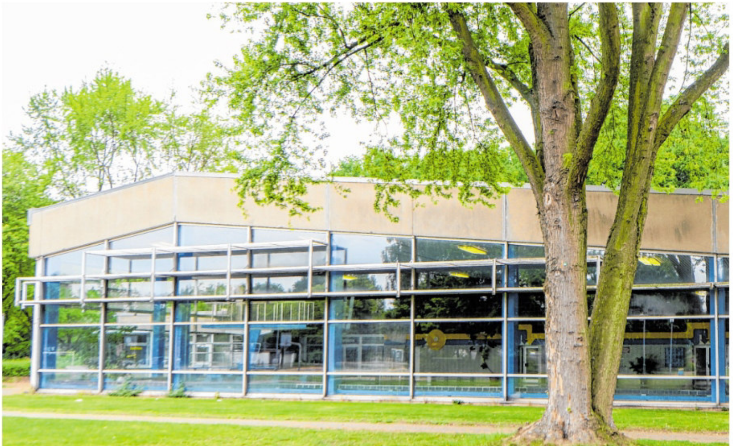
Die Stadt will den technischen Zustand des Hallenbades in Friedrichsfeld durch einen externen Gutachter untersuchen lassen.
