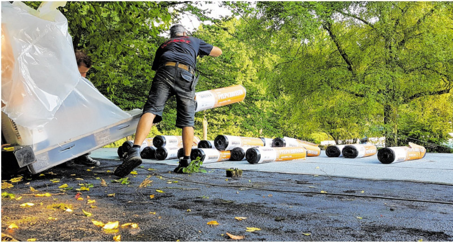
Auf dem Flachdach des Freibadgebäudes wurden neue Bahnen verlegt.
