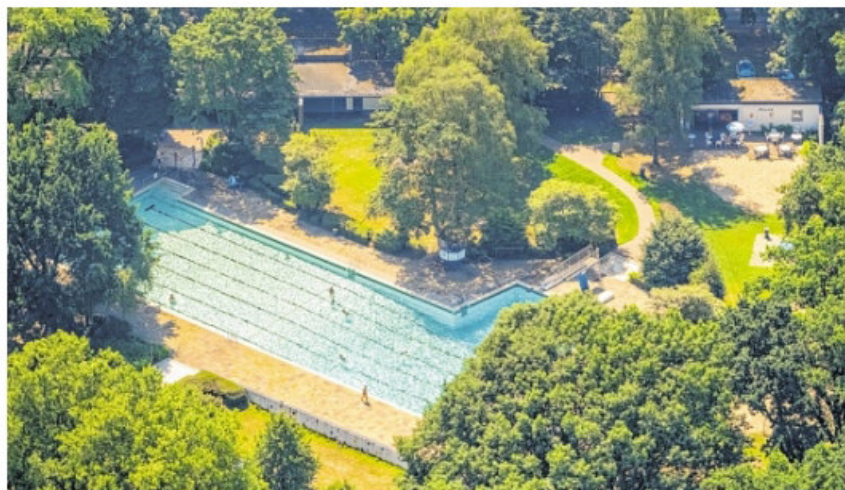
Auf dem Gelände des Freibades an der Allee soll in und für Voerde das neue Kombibad errichtet werden.
