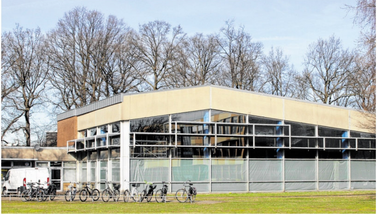
Bis Ende April/Anfang Mai laufen die letzten Arbeiten im Hallenbad. Wegen der früher beginnenden Freibadsaison wird das Bad in Friedrichsfeld vorerst nicht geöffnet. Ein Parallelbetrieb werde als nicht sinnvoll erachtet, erklärt Beigeordneter Wilfried Limke.
