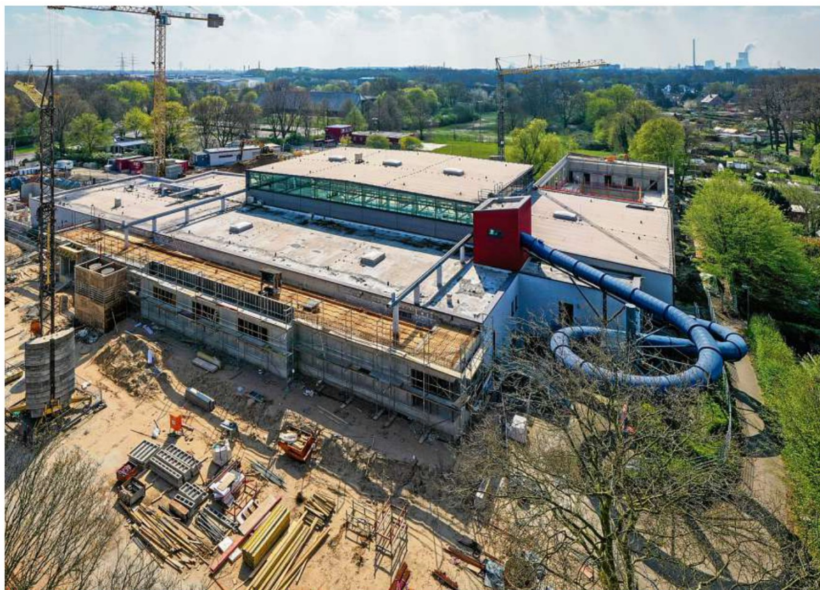
Das Dinamare in Dinslaken ist zurzeit eine große Baustelle.
