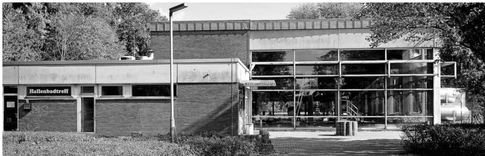
Das Hallenbad in Voerde steht wegen Corona für den Breitensport nicht zur Verfügung. Der Schwimmunterricht der Schulen findet hier aber weiterhin statt.
