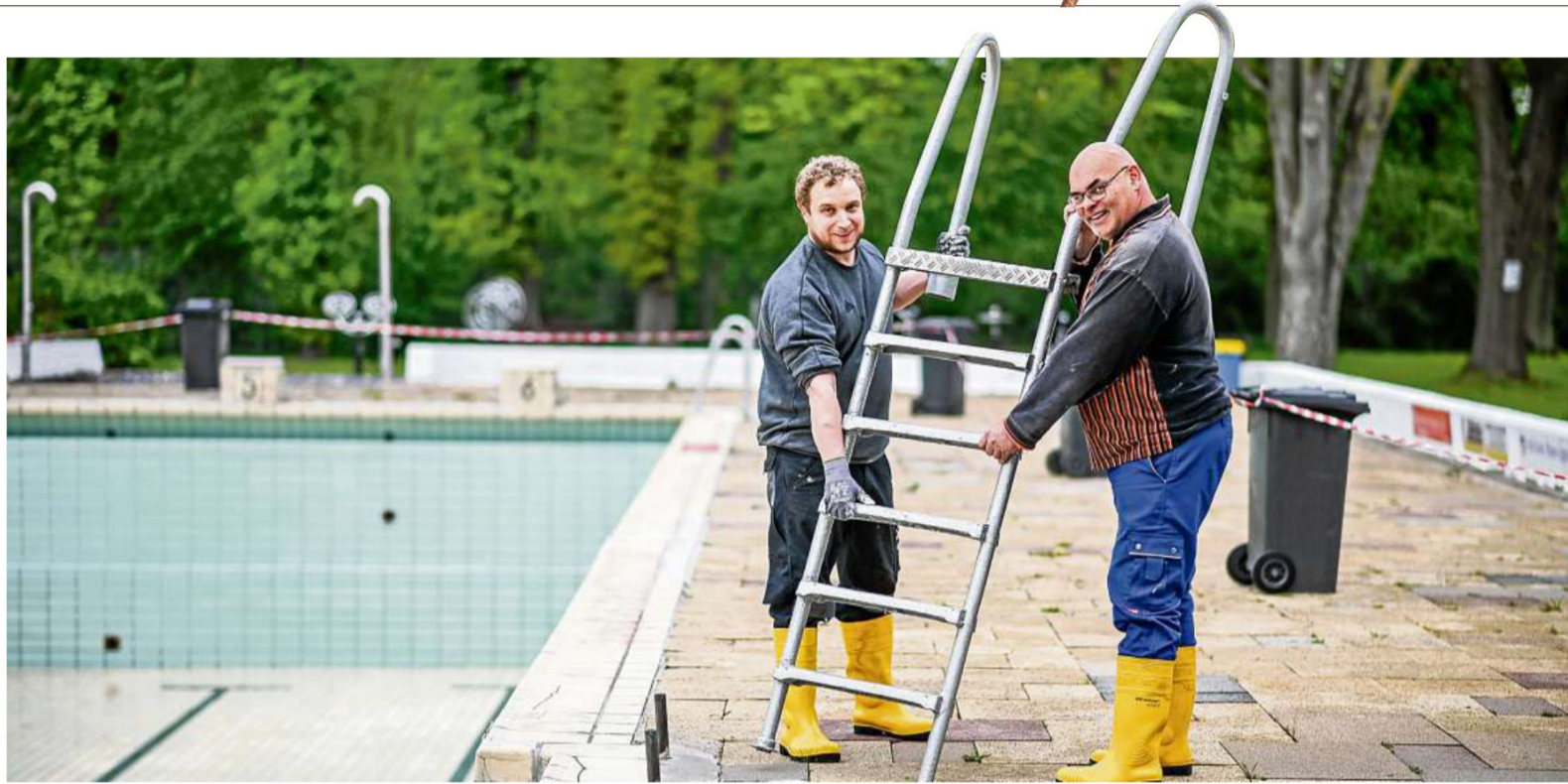
Holger Rissel und Christian Lambrecht installieren die Leitern am 50-Meter-Becken.
